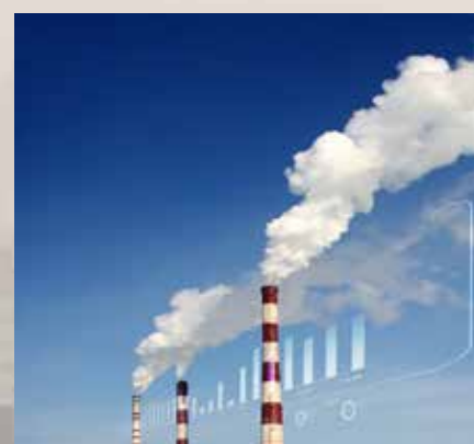
In de schouwen worden meters en sensoren (flow, temperatuur, vochtigheid) gemonteerd. De informatie wordt met behulp van Moxa technologie verzameld en naar de centrale database doorgestuurd.
